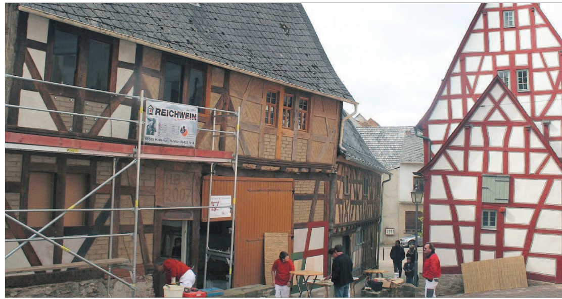
Das Gebäude links wird zum neuen Sitz der Firma Birkenfeld umgebaut, schon fertig ist der Haus des Architekturbüros Dreier rechts.
